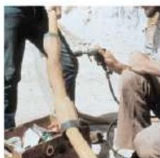
Kit especial para unión de cables mineros flexibles tripolares tipo SHD-GC hasta 25 kV. La chaqueta exterior, con adhesivo sellante, es resistente a la abrasión y a los rayos UV.
